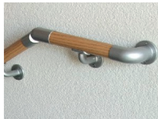
30 cm über die letzte Stufe, mit Abschlussbögen
