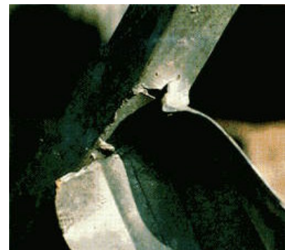
Abb. 10: Konstruktion aus Rechteckhohlprofilen, die im Zinkbad als Folge fehlender Bohrungen auseinander gerissen wurde
