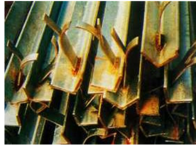
Abb. 18: Fehlstellen im Zinküberzug durch nicht entfernte Schweisschlacken
