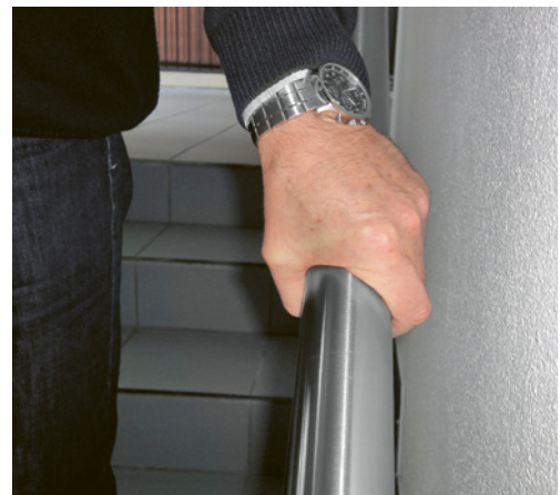
2 Angenehmer Handlauf von 40 mm Durchmesser
